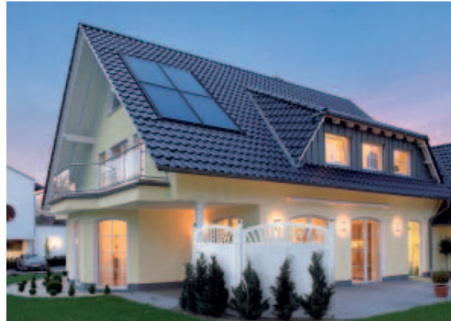
Solarthermieanlage zur Heizungsunterstützung
