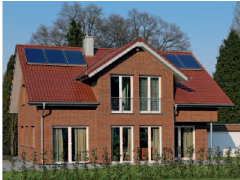
Einfamilienhaus mit Schüco Sole/Wasser-Wärmepumpe HPSol
