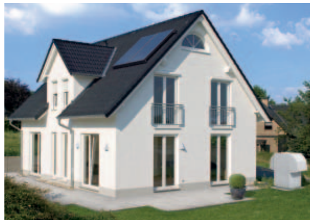
Luft/Wasser-Wärmepumpe mit Solarthermieanlage
