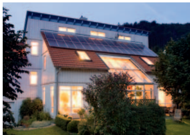
Photovoltaikanlage mit Netzeinspeisung
